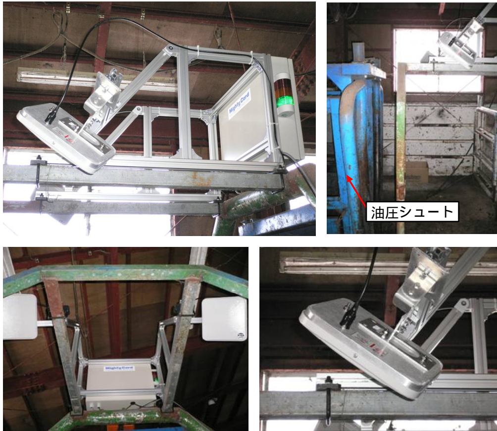
【写真 3.4-1 架台外観】
