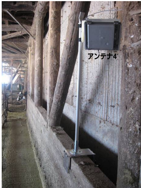
図 3-6 設置型リーダアンテナ設置状況
