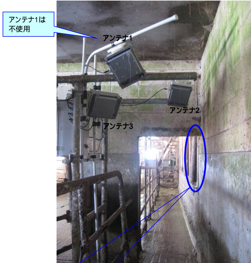
図 3-5 設置型リーダ設置状況
