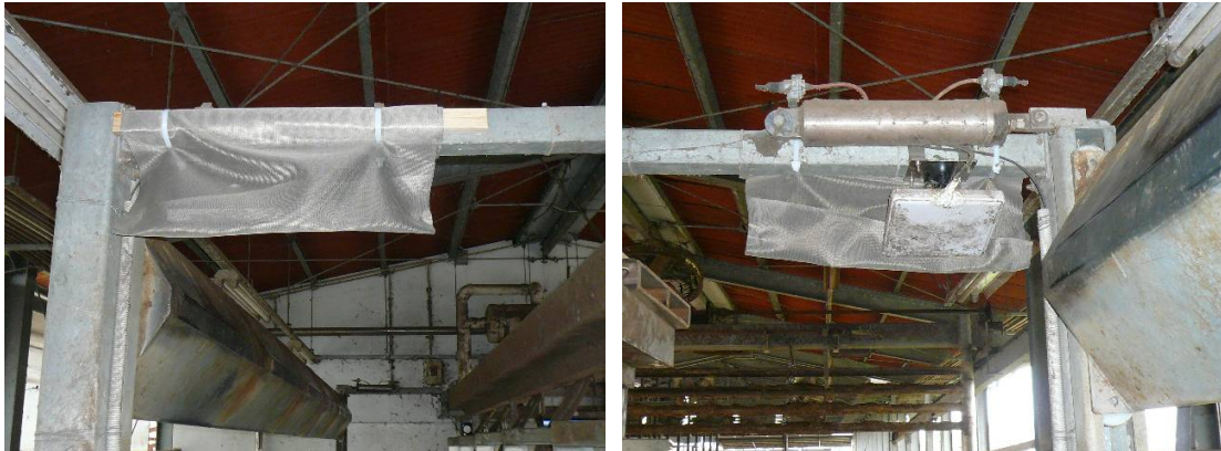
図 2 - 2 - 3 アンテナの取付状況（進行方向左側レーンのアンテナ）
