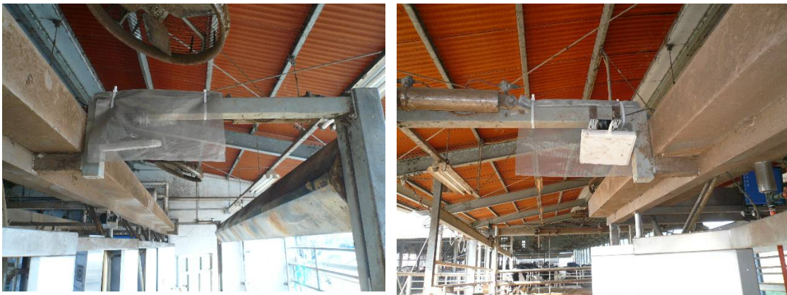
図2-2-2 アンテナの取付状況（進行方向右側レーンのアンテナ）
