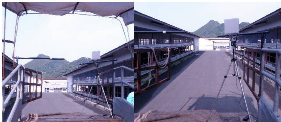
【写真 3-3-3-3-(6)-e-1 スロープ台上に設置】
