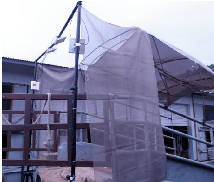
【写真 3-3-3-3-(6)-b-1 電磁波シールド取付け】
