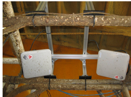
【リーダー制御盤とアンテナ及び架台設置写真】
