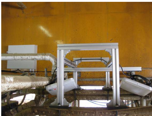
【リーダー制御盤とアンテナ及び架台設置写真】
