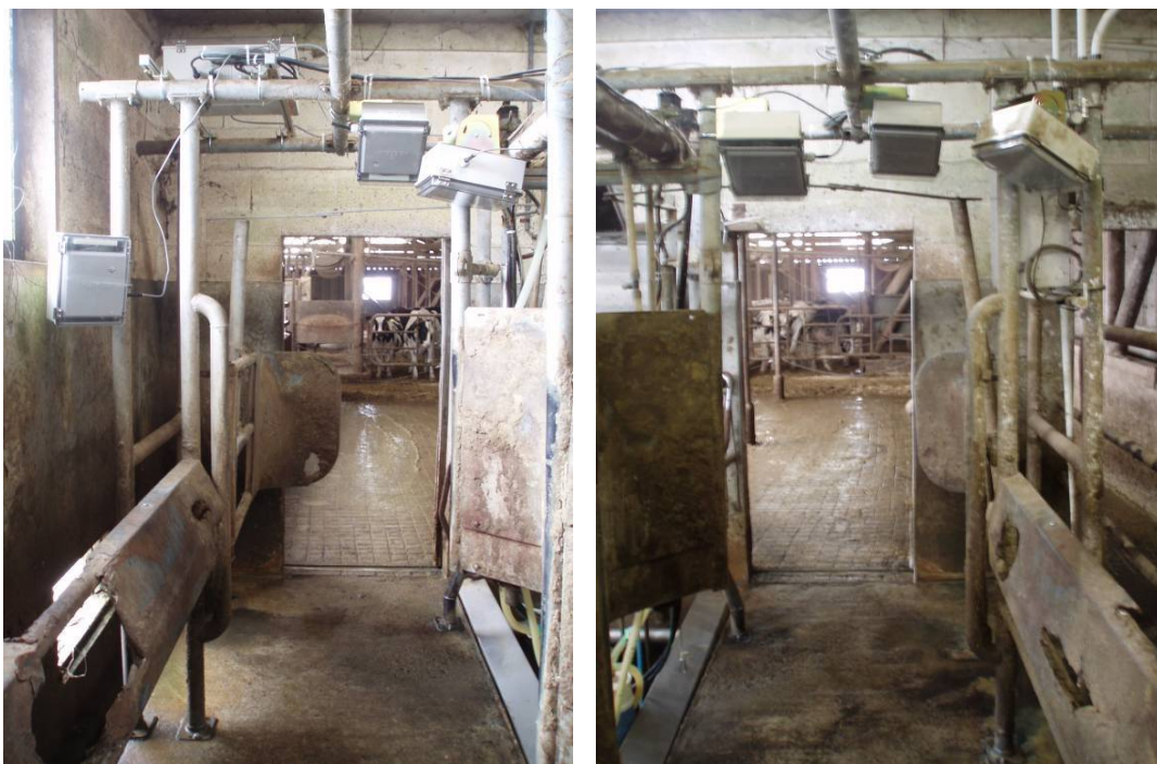
図 4-4 入り口ゲートでのアンテナの設置
