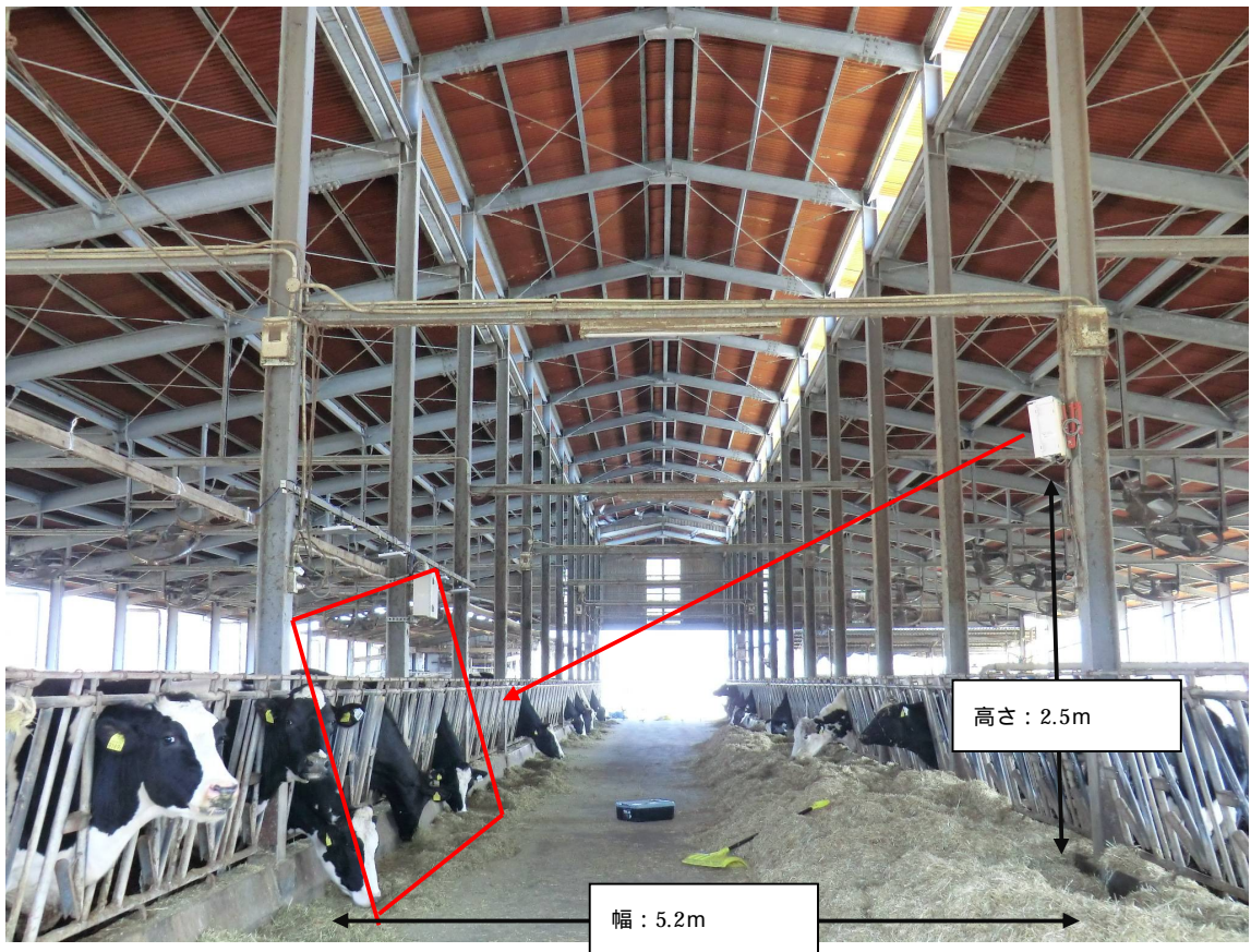
図 2 - 3 - 4 フリーストール内の定点カメラ取付状況
