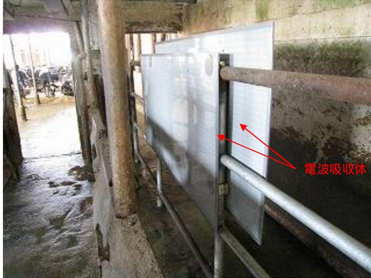
図 17 設置した電波吸収体近景
