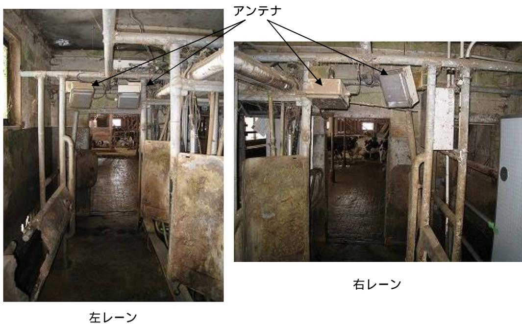
図 13 入り口ゲートでのアンテナの設置
