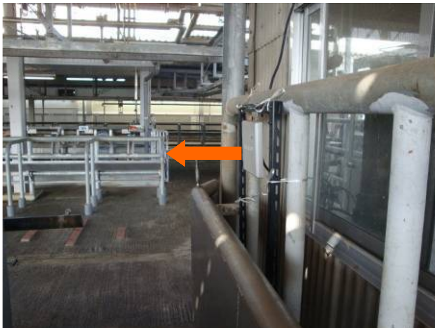
図 26 標準アンテナの設置角度
